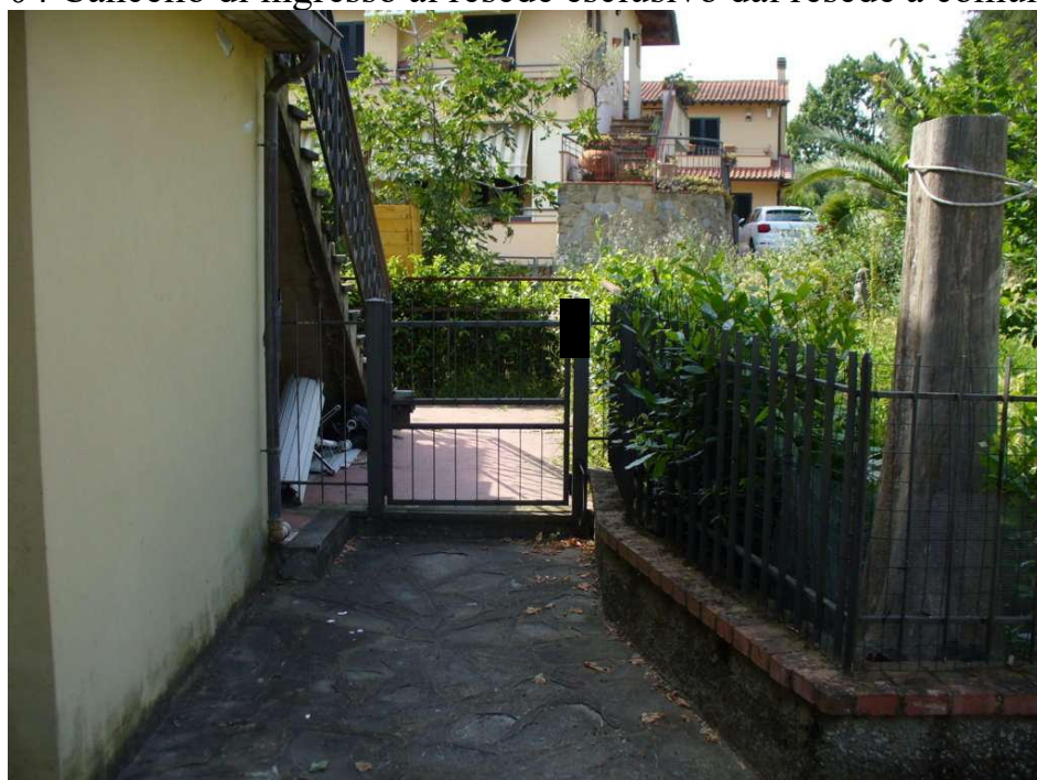
04 Cannello di ingresso al resede esclusivo dal resede a comune alle autorimesse
